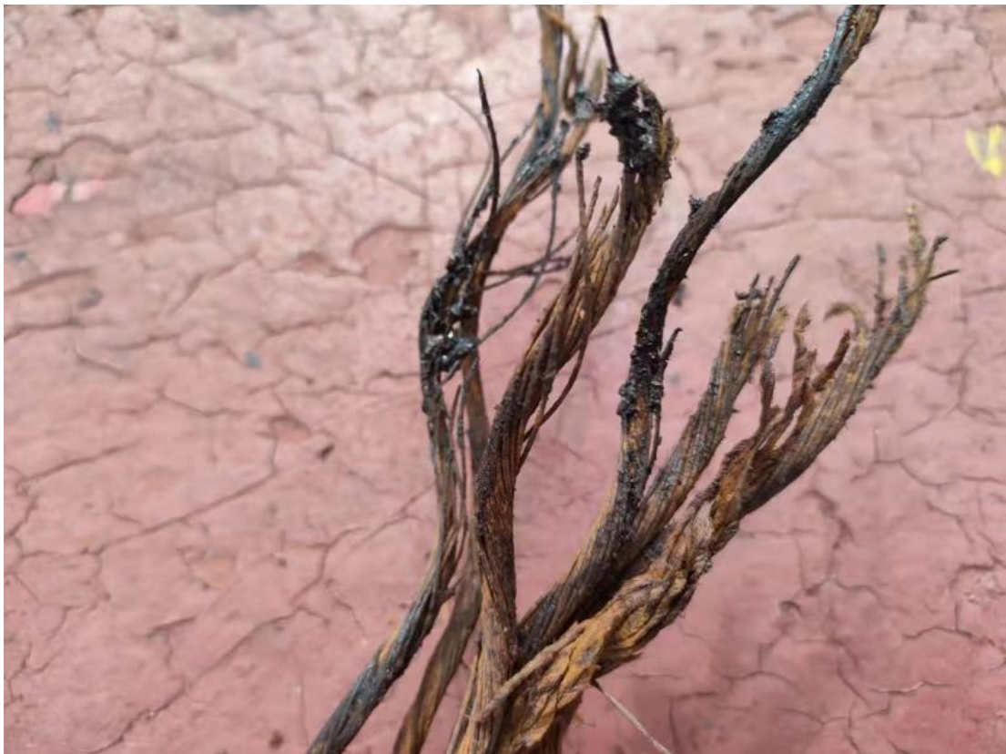
图 4：“华 XX2” 轮舷梯钢丝绳断口处照片
